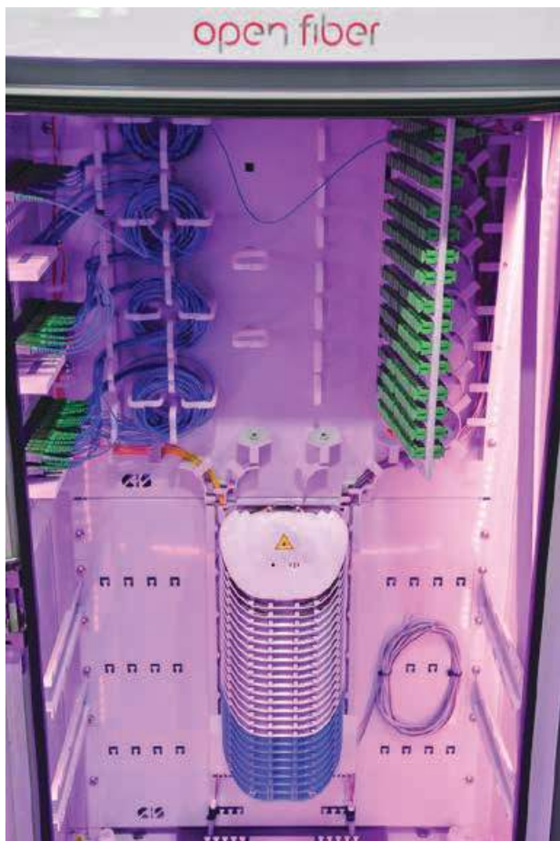
In alto un PFS (punto di flessibilità secondario), elemento di rete in cui avviene il secondo livello di splitting della gpon, che connette in modalità punto-punto 256 unità abitative (pfs-borchia ottica)
