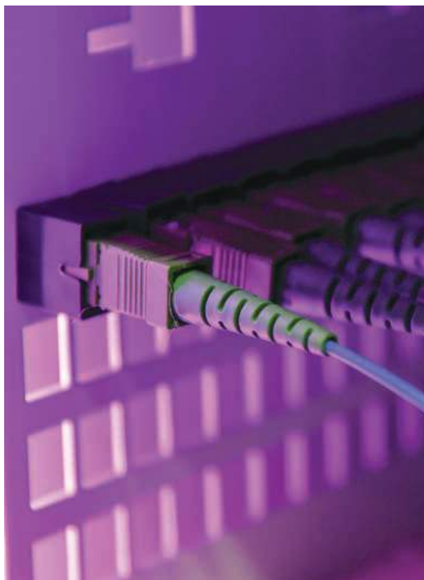
In alto un PFS (punto di flessibilità secondario), elemento di rete in cui avviene il secondo livello di splitting della gpon, che connette in modalità punto-punto 256 unità abitative (pfs-borchia ottica)
